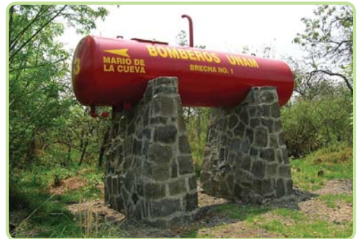
Figura 4. Tanques de agua para abastecer a los camiones de bomberos en caso de un incendio.
