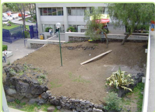
Figura 6. Área verde ubicada en la Facultad de Ciencias. El sitio fue rellenado con suelo extraño al Pedregal después de la construcción del drenaje. FOTO: PEDRO ELOY MENDOZA.
