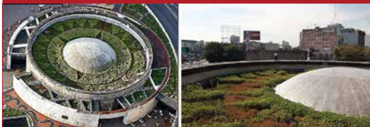
Figura 27. Azotea verde en la estación del Metro Insurgentes, México, D. F.
