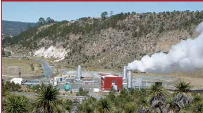
Figura 24. Campo geotérmico Los Humeros, CFE, Puebla, México
