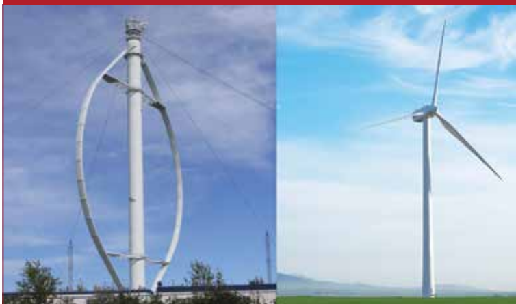
Figura 21. Aerogeneradores: de eje vertical (izquierda); de eje horizontal (derecha)
