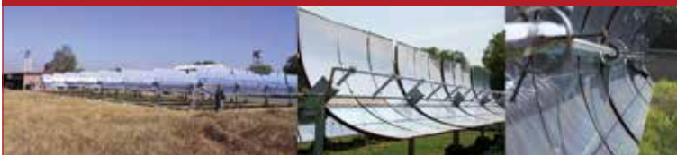
Figura 16. Planta solar, Instituto de Ingeniería, UNAM, México, 1980
